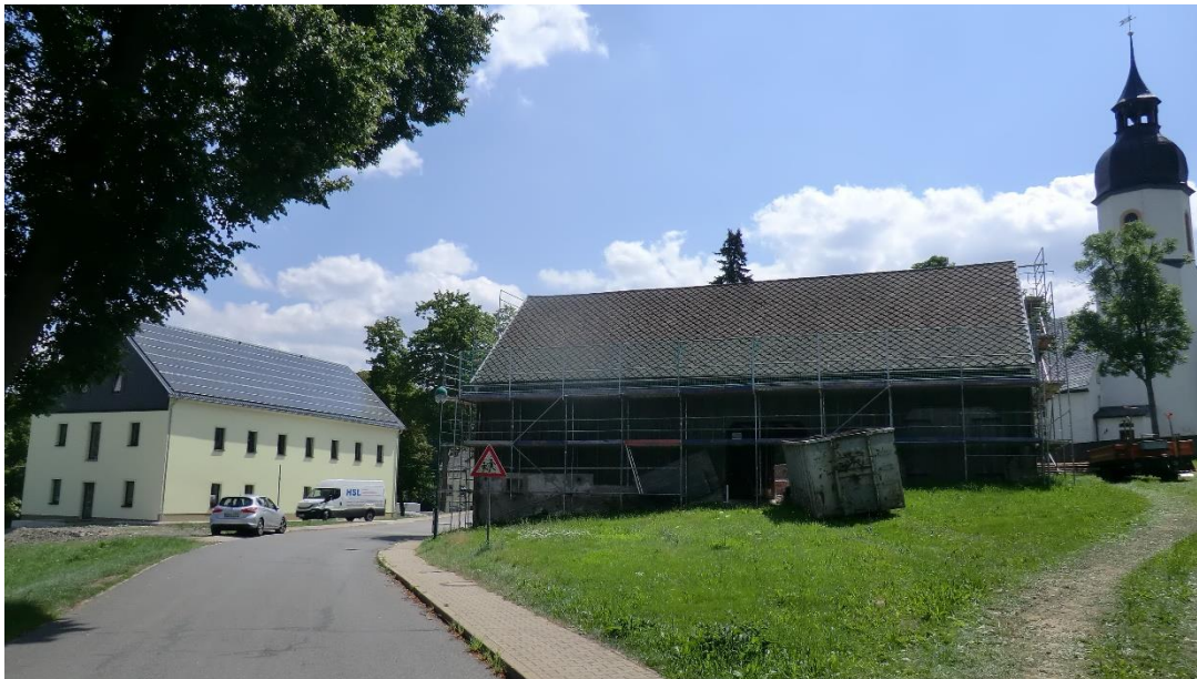
Abbildung 56: Ansicht „Hetzegut“ mit Wohnhaus mit 4 WE (links) und Scheune als künftige Heizzentrale (rechts)
