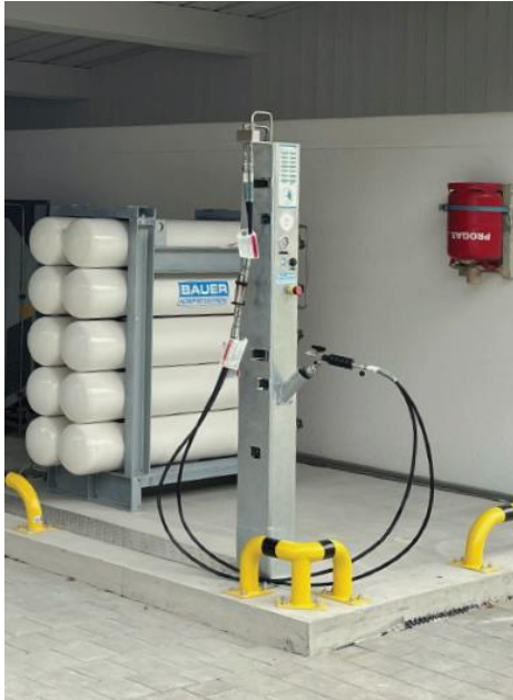
Abbildung 44: Hoftankstelle zur Betankung von CNG-Fahrzeugen
