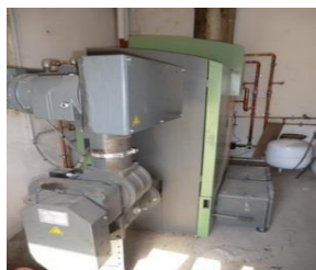
Hackschnitzel- Feuerungsanlage*
